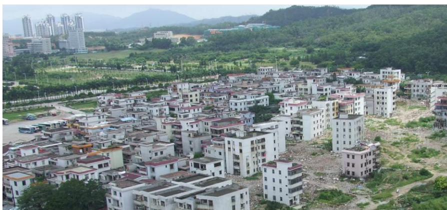
图 4-1 山场村改造进行中历史照片 资料来源：笔者自摄
