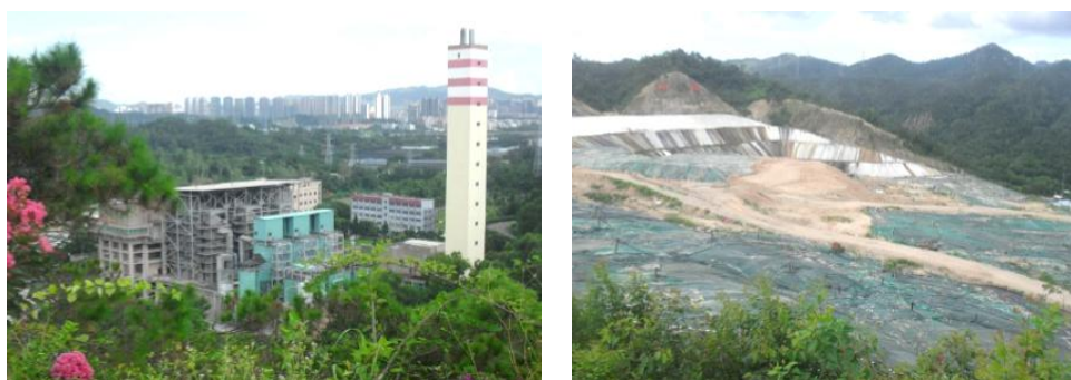
图 4-9 沥溪福溪村周边环卫设施 资料来源：笔者自摄
